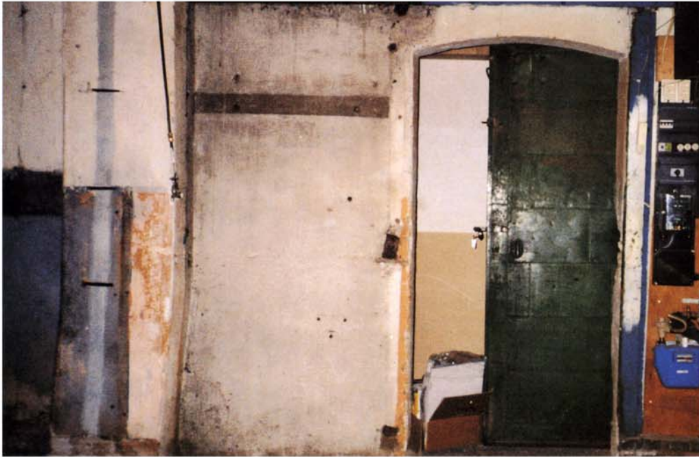
Om het pand op te knappen, waren behoorlijke renovatieverken nodig.
